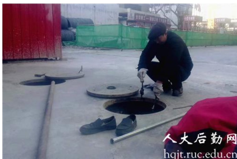
▲抢修施工工地地下供水管道
